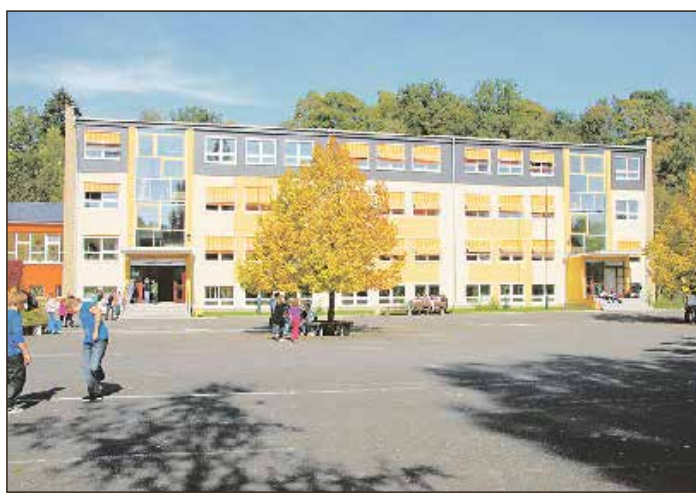
Nur die Schulen haben keine Ferien. Auch in diesem Sommer stehen an Schulen im Landkreis wieder umfangreiche Sanierungsarbeiten an. Foto: LRA
