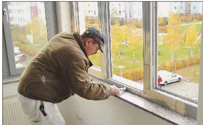
Ein repariertes Holzfenster kann nach dem Anstrich wieder wie neu aussehen. Foto: djd/Repair Care International B.V.
