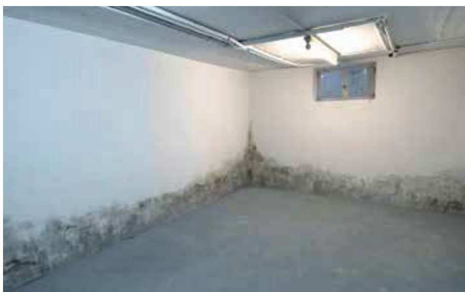
Beispielhafte Schadensbilder bei defekter Horizontalsperre
