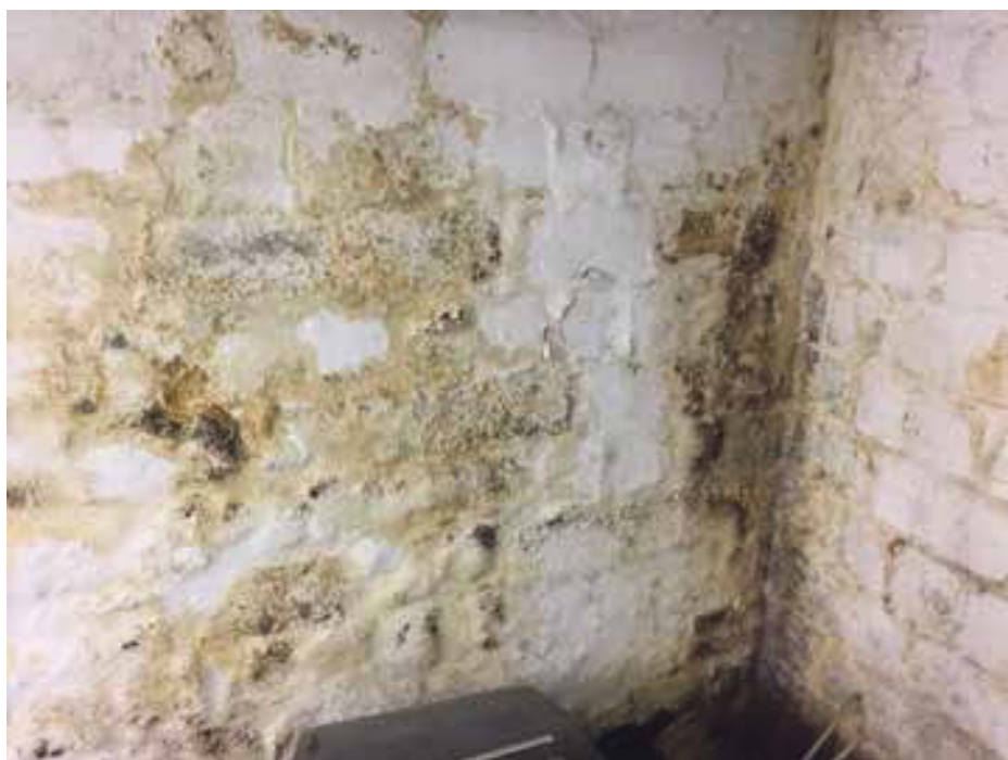
Beispielhafte Querdurchfeuchtung
